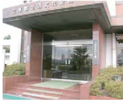
▲三原郡生活文化会館 (三原町市善光寺)
